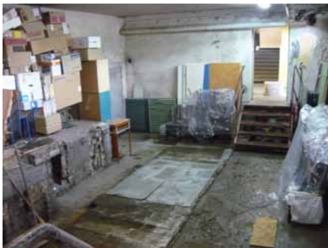
Zdjęcie 8. Kotłownia – porządki czas zacząć.
